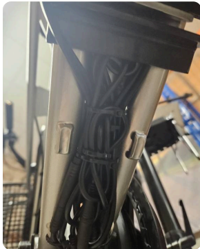
Connecteurs et surplus serrés aux colliers.
